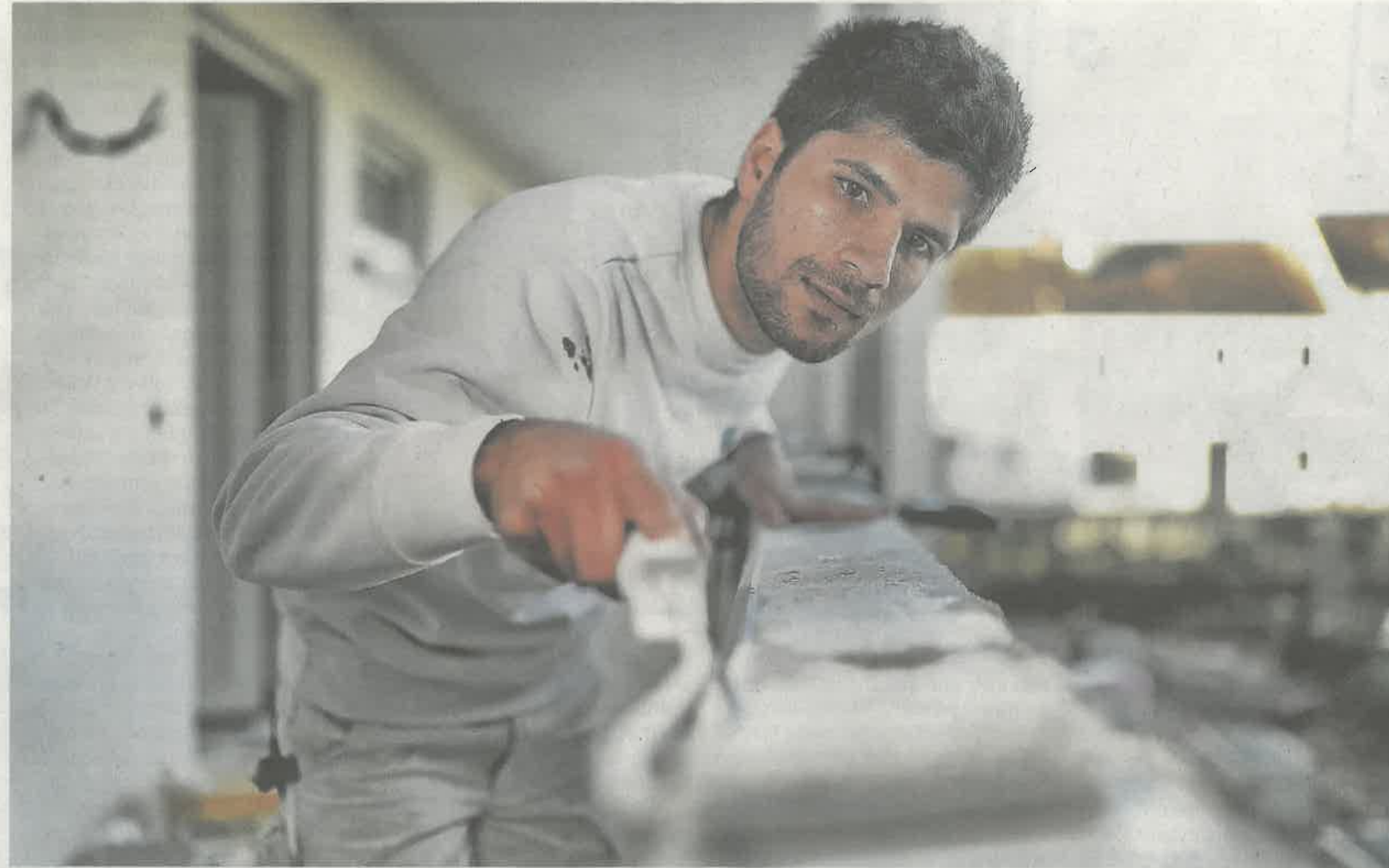
Milad Nikraftar Haghhighifard bei der Arbeit auf einer Baustelle in Mettmann. Er ist Azubi bei der Firma Weiss zum Maler und Lackierer.
